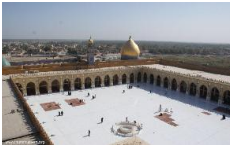
مسجد کوفه پس از بازسازی بهره‌ها
